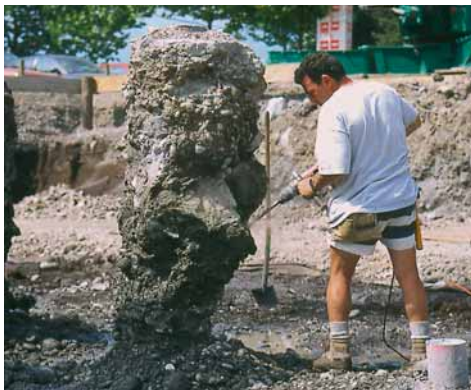
Nel palo iniettato è ben visibile lo sbulbamento della miscela cementizia nel terreno.
