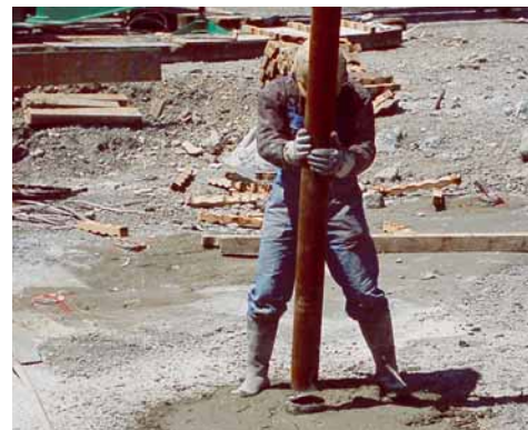
Inserimento del nuovo spezzone nel giunto F conico del tubo precedentemente infisso.
