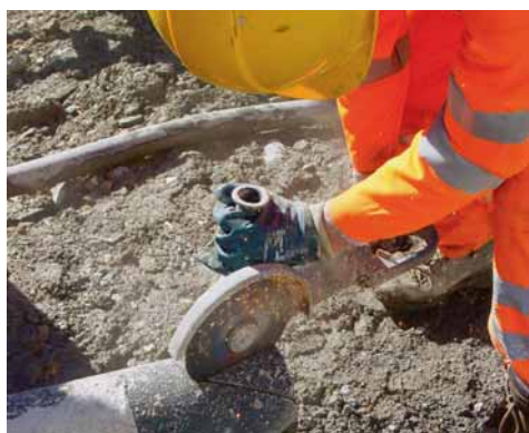
Nello spezzone di piede del palo viene ricavata la luce di fuoriuscita della malta cementizia.
