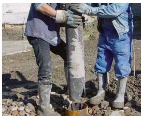
Il primo spezzone di palo viene attrezzato con punta a perdere.
