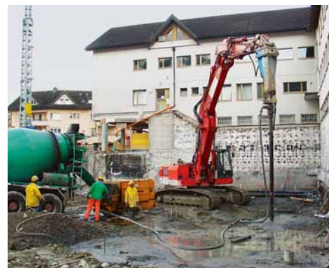
Il basso livello di vibrazioni indotte consente di lavorare nelle vicinanze di manufatti esistenti.
