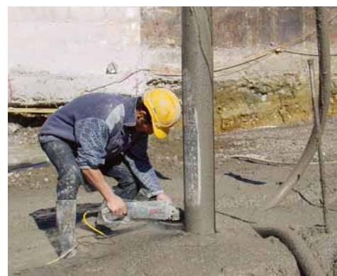
La lunghezza di tubo eccedente viene tagliata con un flex e riutilizzata come primo spezzone del palo successivo.
