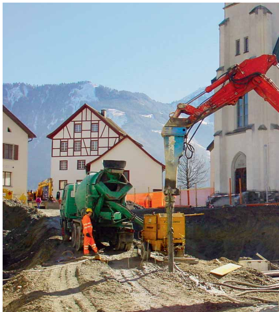
I pali vengono infissi in sequenza per mezzo di un martello idraulico montato su escavatore a braccio rovescio.
