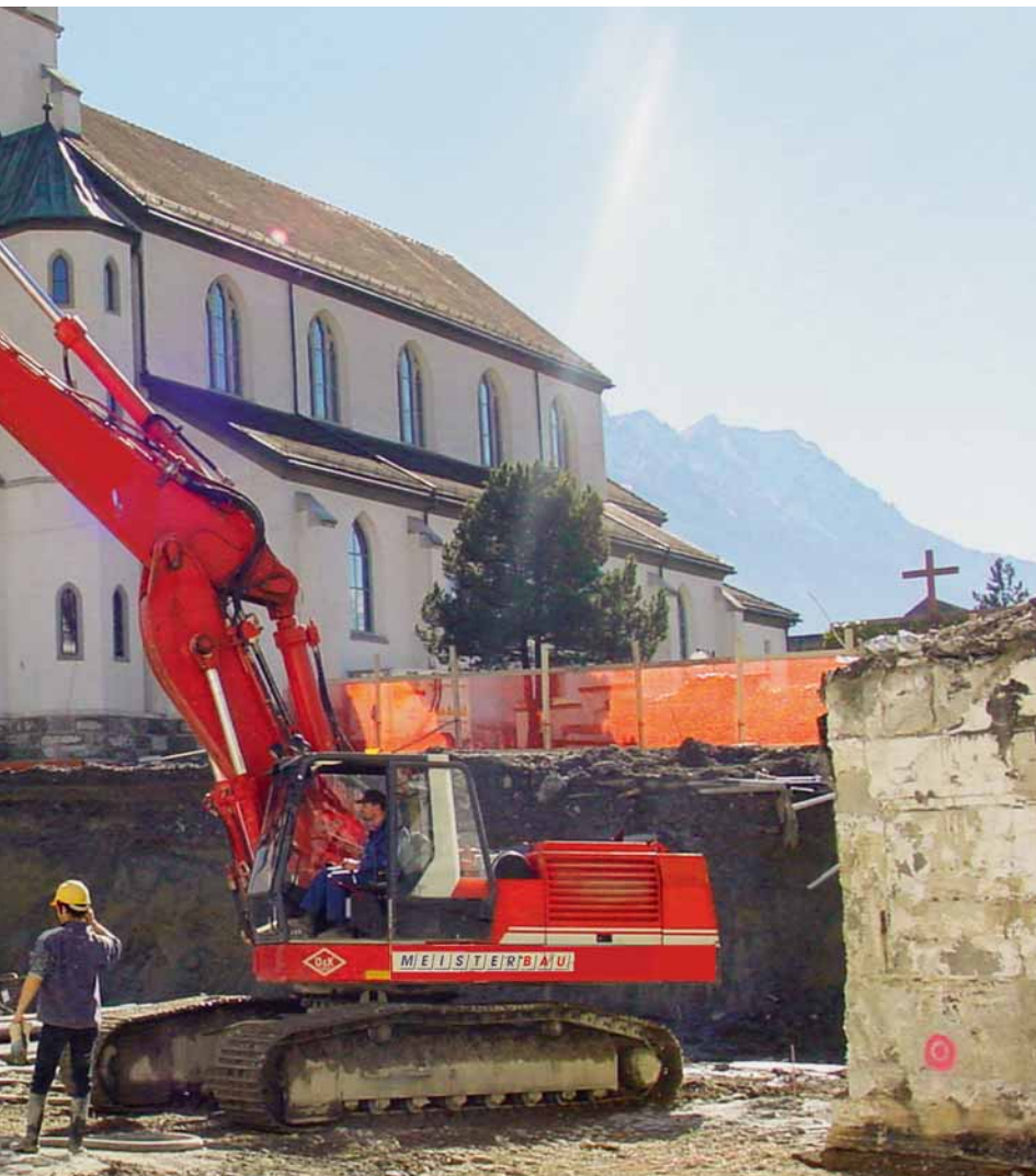
Ein weiterer Pfahl wird auf einen schon gerammten Pfahl gesetzt.
