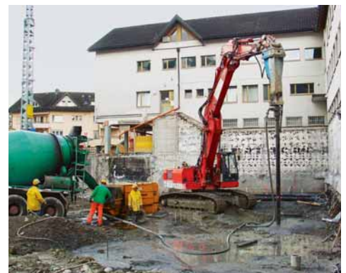
Nahezu erschütterungsfreies Arbeiten ermöglicht Rammung nahe bestehender Gebäude.
