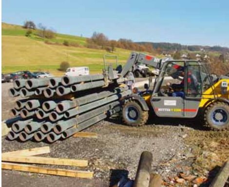
Die Pfähle können mit leichtem ausgebildet. Gerät vom Laster abgeladen und auf der Baustelle transportiert werden.
