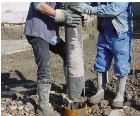
Das Einsetzen des Pfahles in den Pfahlschuh.
