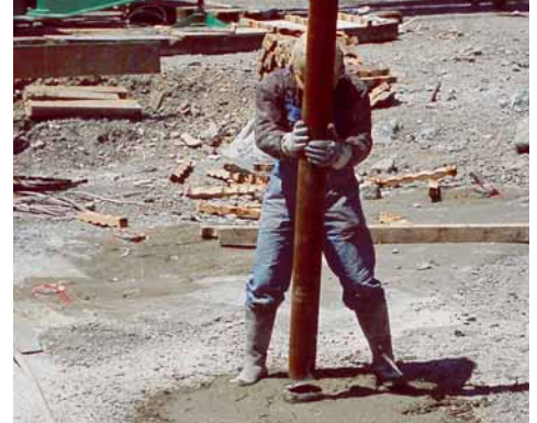
Ein weiterer Pfahl wird auf einen schon gerammten Pfahl gesetzt.
