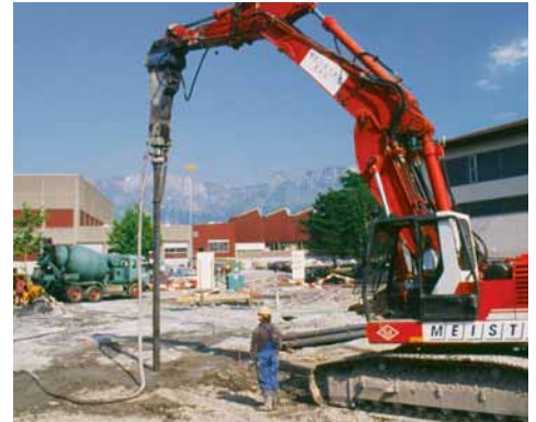
Einfache Baustelleneinrichtung: Bagger, Betonlaster, Betonpumpe, Rohre und Rammhammer.
