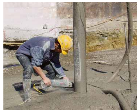
Das überstehende Pfahlstück wird auf einfache Weise mit der Trennscheibe abgesägt und kann als Anfangsstück wieder verwendet werden.
