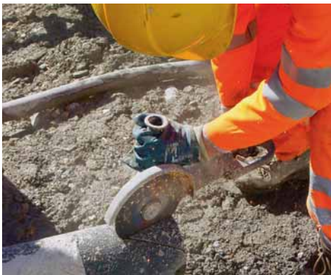
Dem ersten Pfahl wird ein Schlitz für den Betonaustritt eingesägt.
