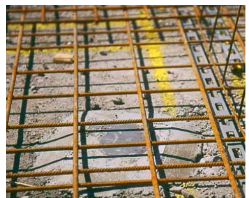
Mit einer Platte abgeschlossener Pfahl und Armierung fertig für den Betonguss.
